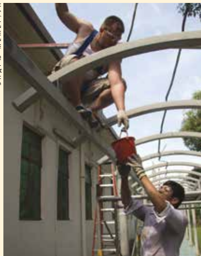
ПРОЦЕСС СТРОИТЕЛЬСТВА: Находясь в учебной поездке на Филиппинах, студенты инженерного факультета университета Андриуса работают с местными жителями над ремонтом крытого прохода возле церкви.
